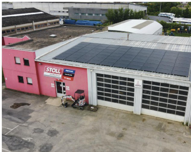
L'agence luxembourgeoise de Manuloc vient de s'équiper de panneaux solaires afin d'être autonome énergétiquement.
